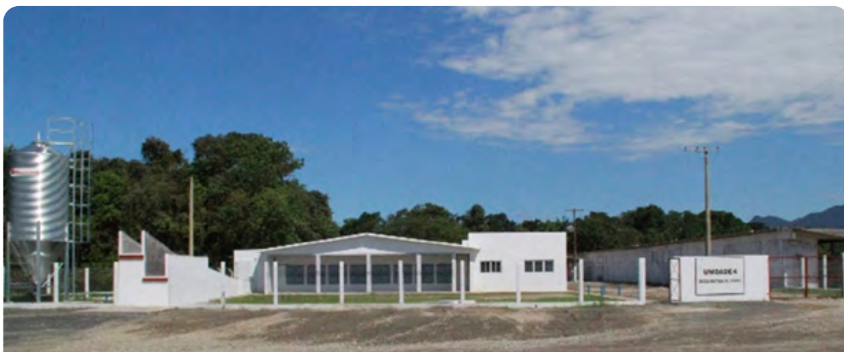
Galpão da Estação Quarentenária de Cananéia
